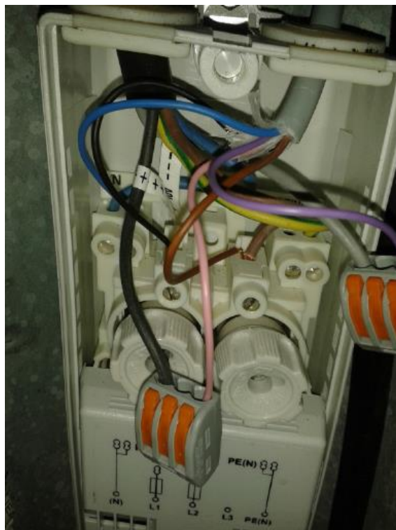
Figure 5: Photographie d'un porte-fusible
